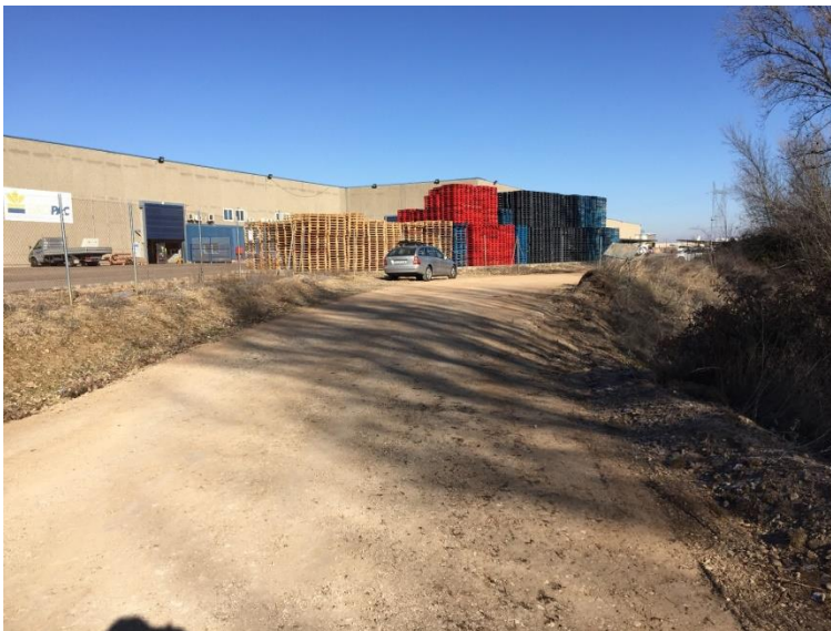
Ilustración 7.- Ámbito donde se corrige el trazado del camino actual y se realiza el cambio de clasificación del suelo de sus terrenos de suelo protegido a suelo urbano como la parcela aledaña de la que formará parte.
