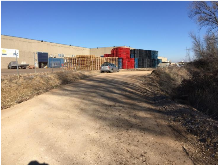
Ilustración 4.- Camino actual y curva donde se proyecta la rectificación del mismo. El camino actual pasa a ser suelo urbano industrial de la parcela de EUROPAC con el cambio del camino.
