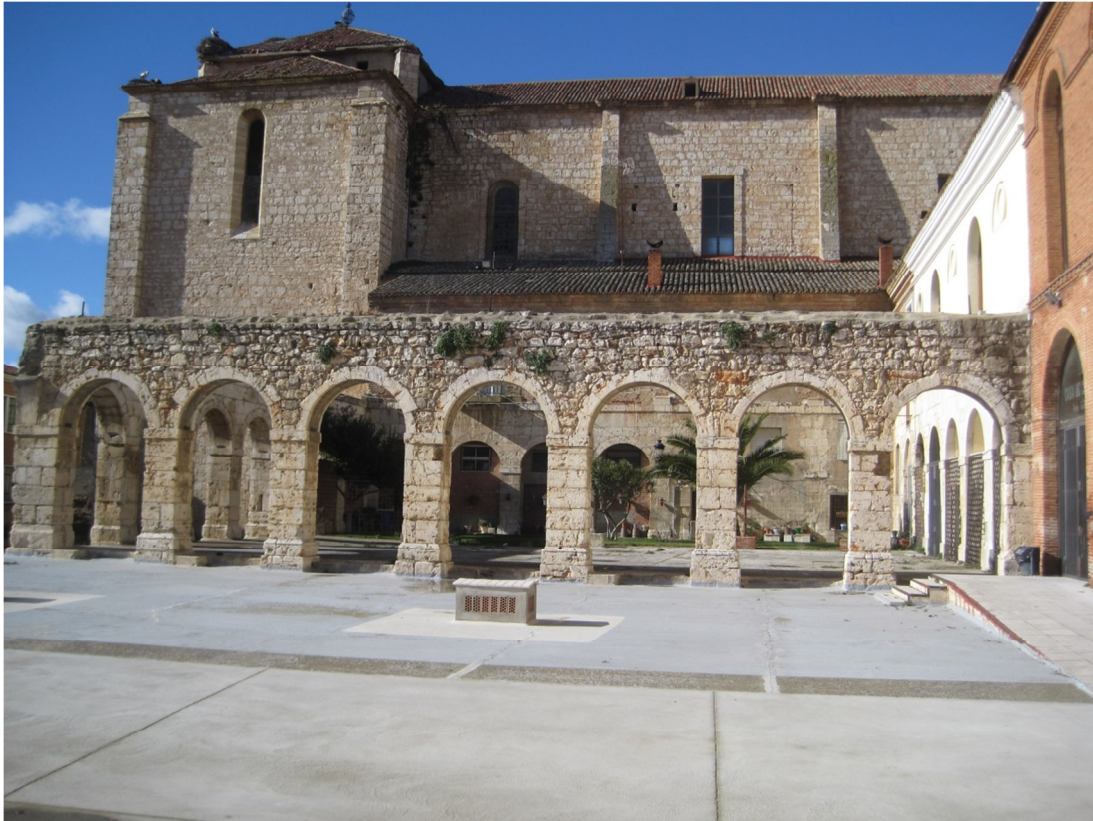
PATIO DE ARCOS
