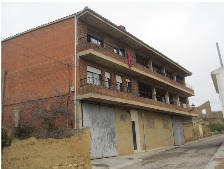
Edificios de viviendas que necesitan regenerarse.
