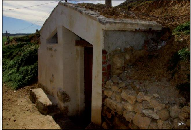
Fachada con mampostería sana y longitud considerable, en bodega situada en la calle Travesía Ctra. De Ampudia. Recalce de fachada realizado recientemente mediante hormigón gris a la vista, con la finalidad de paralizar el desplome progresivo que sufría dicha fachada y reducir riesgos de daños personales por derrumbes hacia espacios de libre tránsito, así como la ejecución de menor volumen de obra en su posible reconstrucción.
