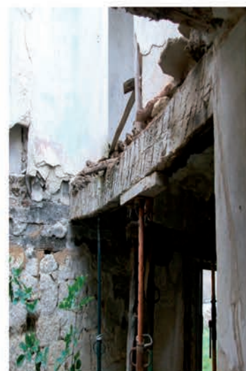
Apuntalamiento interior del palacio
