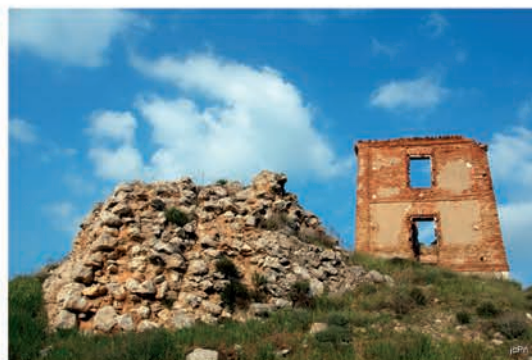
Telégrafo de Tariego con restos de anterior edificación
