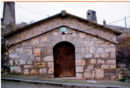
Pequeña fachada de construcción y reformas mimadas por el barrio de Sta. Marina, con arco adovelado, triangulo de ventilación, carpintería de madera y doble
