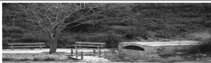
Estado actual de la fuente de Villafaldetas.
