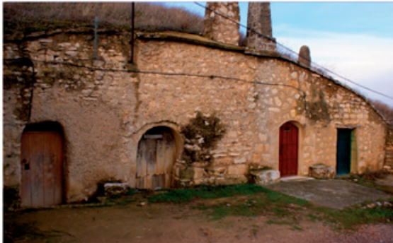
Atractiva fachada de cuatro bodegas por Santa Marina con alineación y coronación curva regulada. Huecos de puerta arcados en tres y su carpintería de madera. Revestimientos de mampostería mayormente visible.
